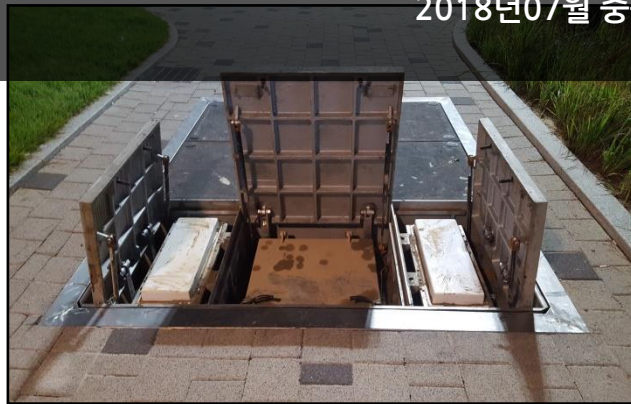
*고압 변압기 (지하매설식 기기함, 22,900V, 500KAV) 2018년07월 중구 장충동 7대 설치
