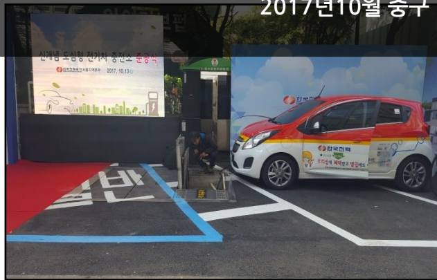
*전기차 충전 인버터 (지하매설식 기기함) 2017년10월 중구 다동 노상 주차장 설치
