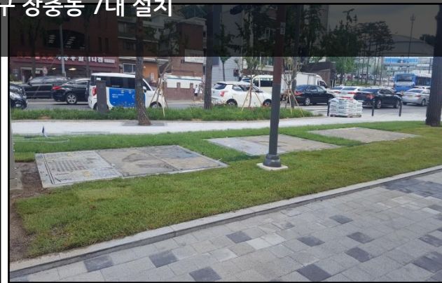
*고압 변압기 (지하매설식 기기함, 22,900V, 500KAV) 2018년07월 중구 장충동 7대 설치
