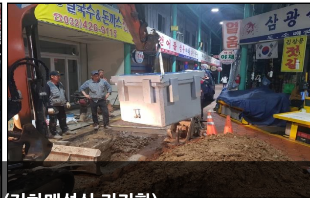
*시민 자율 소방함 (지하매설식 기기함) 2018년07월 종로구 광장시장 설치-2019년 전국적으로 확대 설치 중
