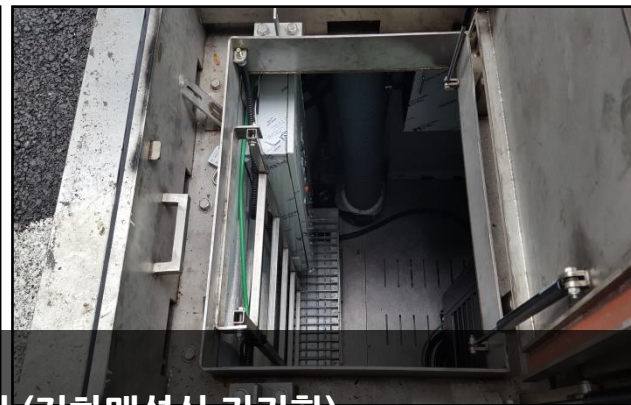
*전기차 충전 인버터 (지하매설식 기기함) 2017년10월 중구 다동 노상 주차장 설치
