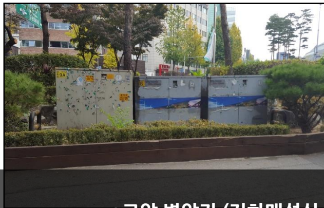
*고압 변압기 (지하매설식 기기함, 22,900V, 500KAV) 2018년07월 중구 장충동 7대 설치
