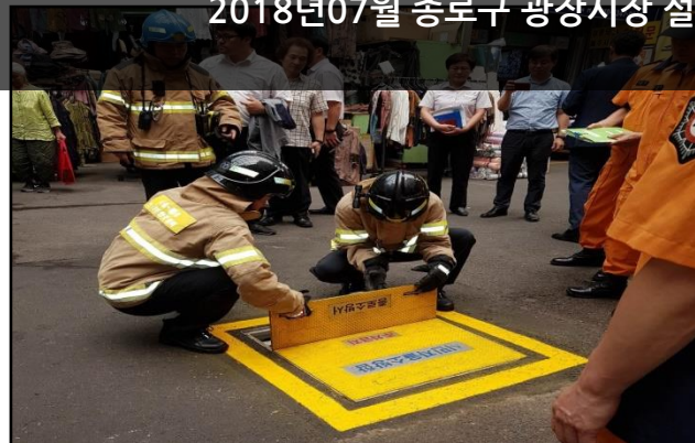
*시민 자율 소방함 (지하매설식 기기함) 2018년07월 종로구 광장시장 설치-2019년 전국적으로 확대 설치 중
