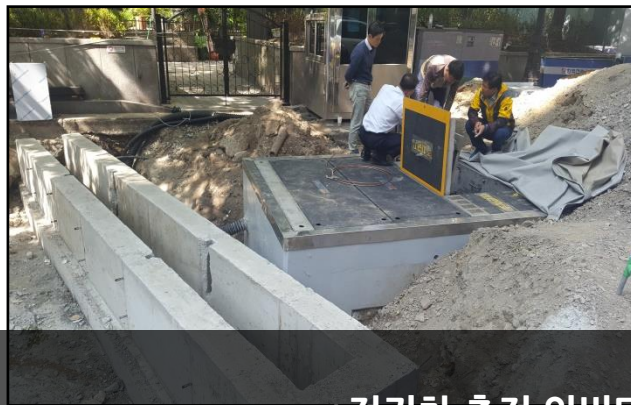
*전기차 충전 인버터 (지하매설식 기기함) 2017년10월 중구 다동 노상 주차장 설치
