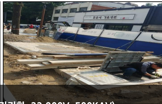
*고압 변압기 (지하매설식 기기함, 22,900V, 500KAV) 2018년07월 중구 장충동 7대 설치
