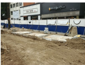
한전 변압기를 지하에 매설하는 공사를 하는 모습
